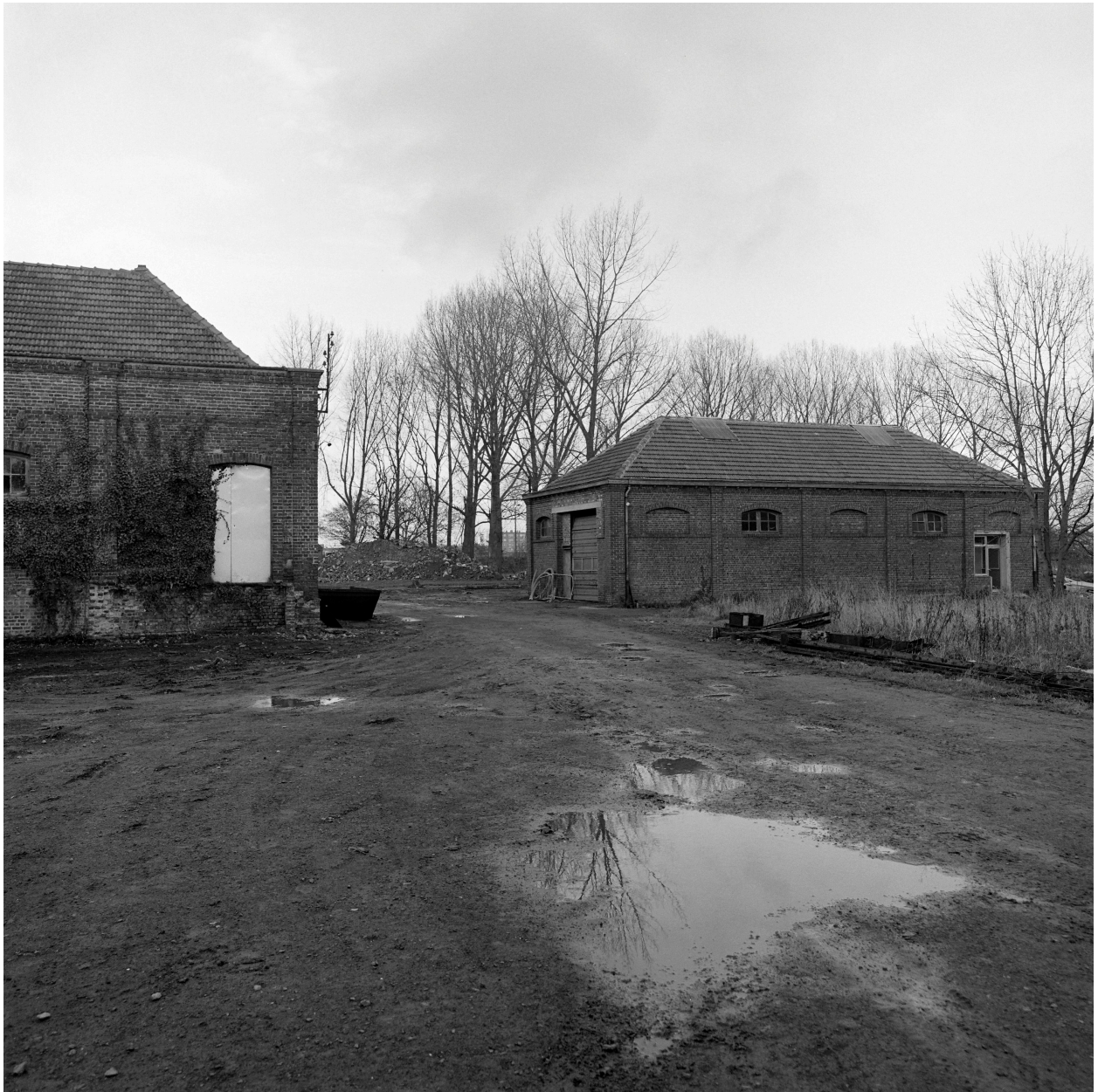
Entrepôt industriel (G), vue prise vers l'est.
