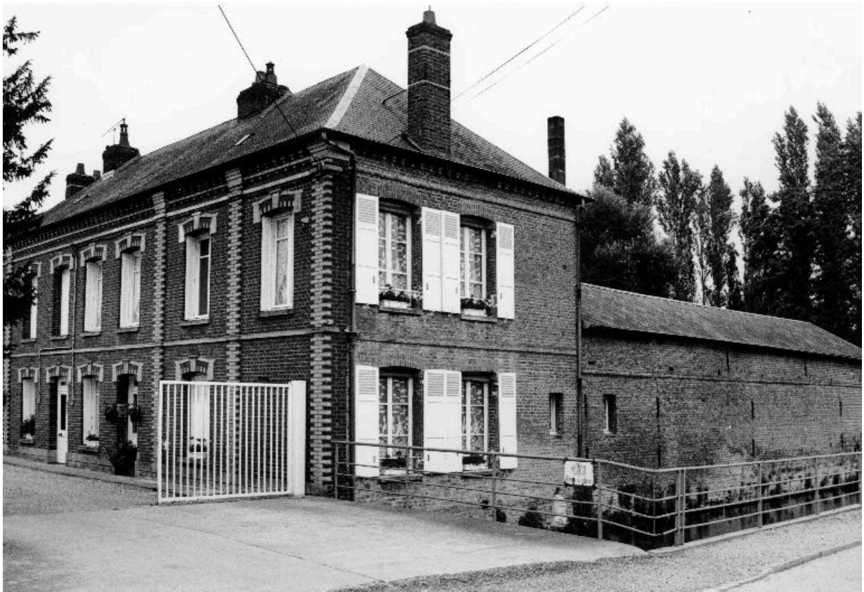
Logement de contremaître.
