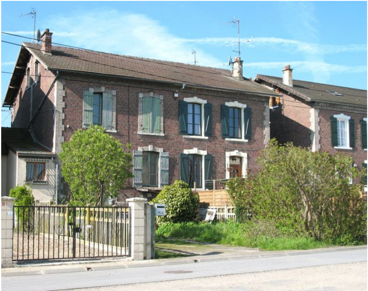
Maison à quatre logements de la cité Louis Blanc.
