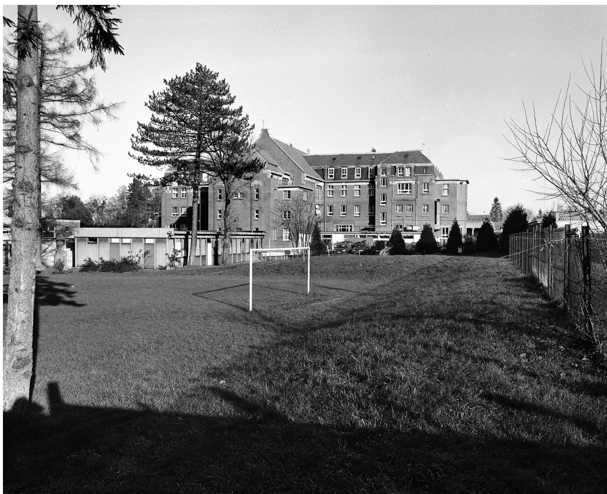
Vue générale du pensionnat depuis le sud.
