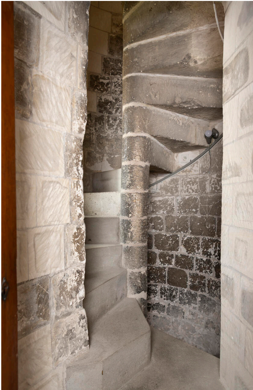
Vue de l'escalier à vis desservant les différents étages du beffroi.
