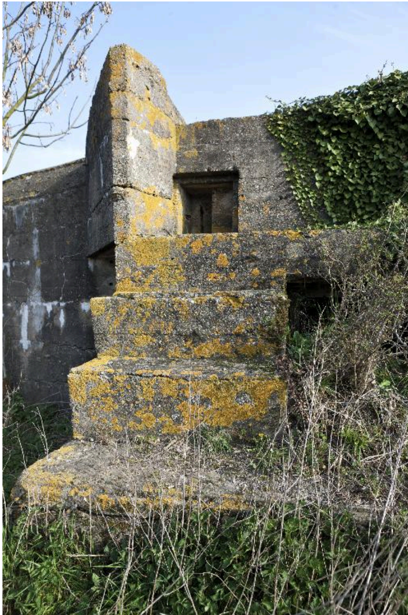
Escalier menant au poste de mitrailleuse. Au centre, la niche à mitrailleuse, en haut et à gauche, celle à munitions
