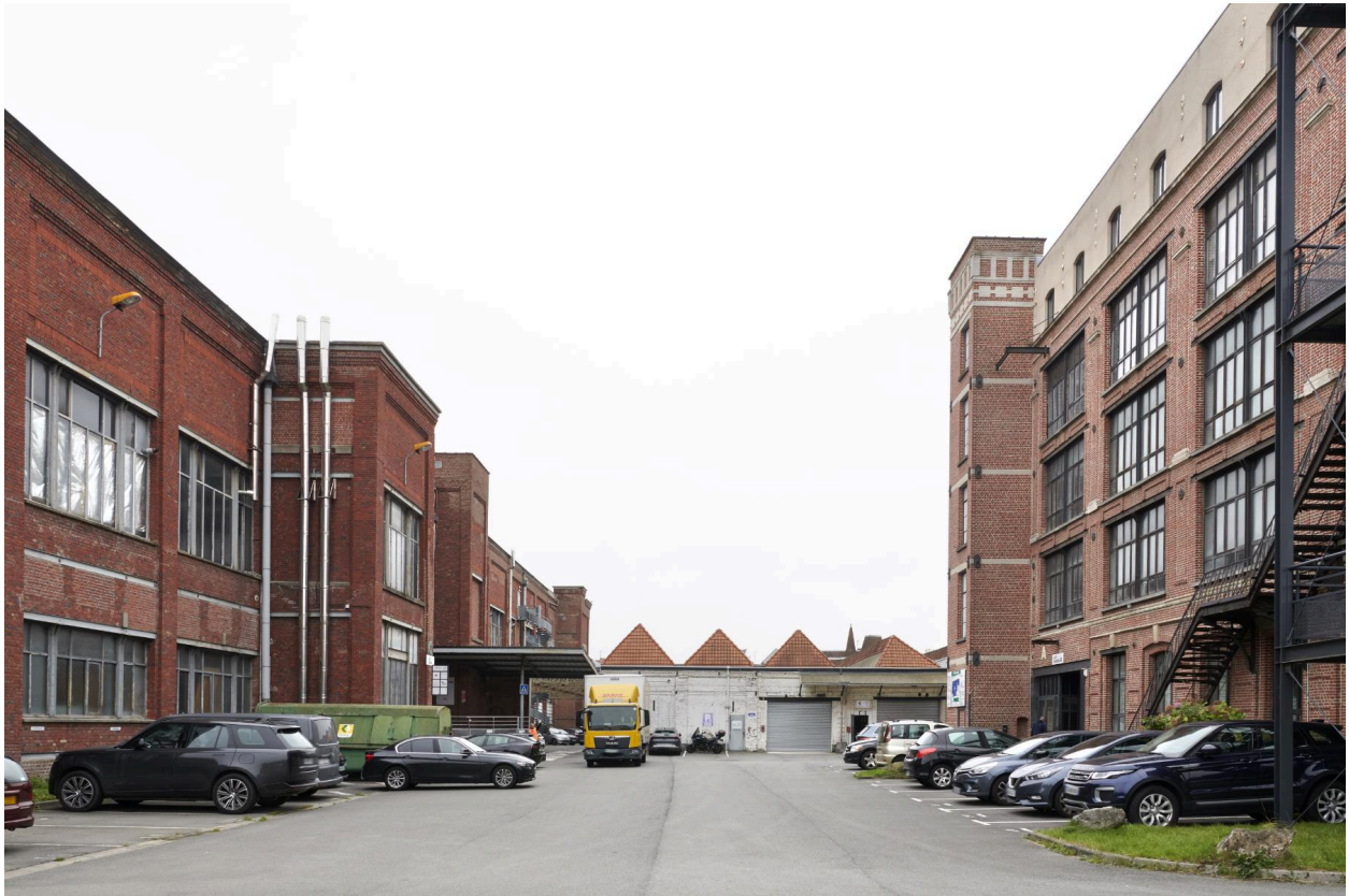
Bâtiments sur la cour intérieure, vue générale.
