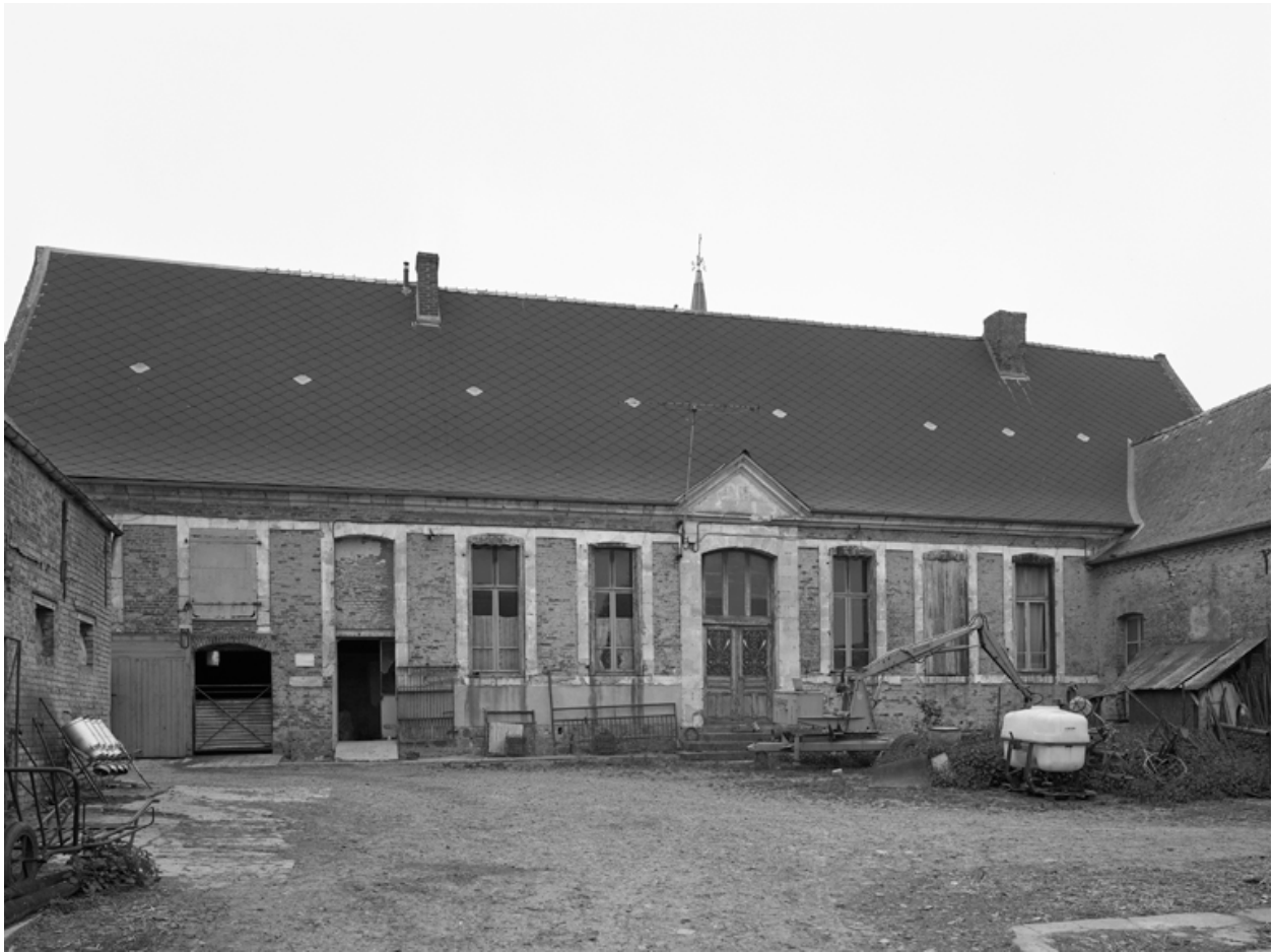
Elévation sur cour du logis prioral, édifié au milieu du 18e siècle.
