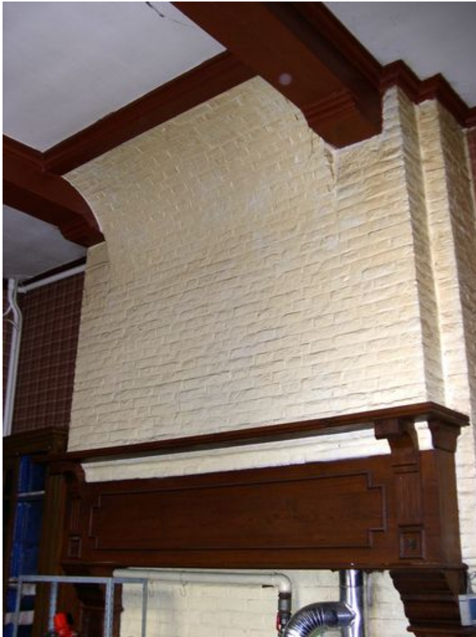
Intérieur, rez-de-chaussée, pièce sud-est : trumeau de cheminée.
