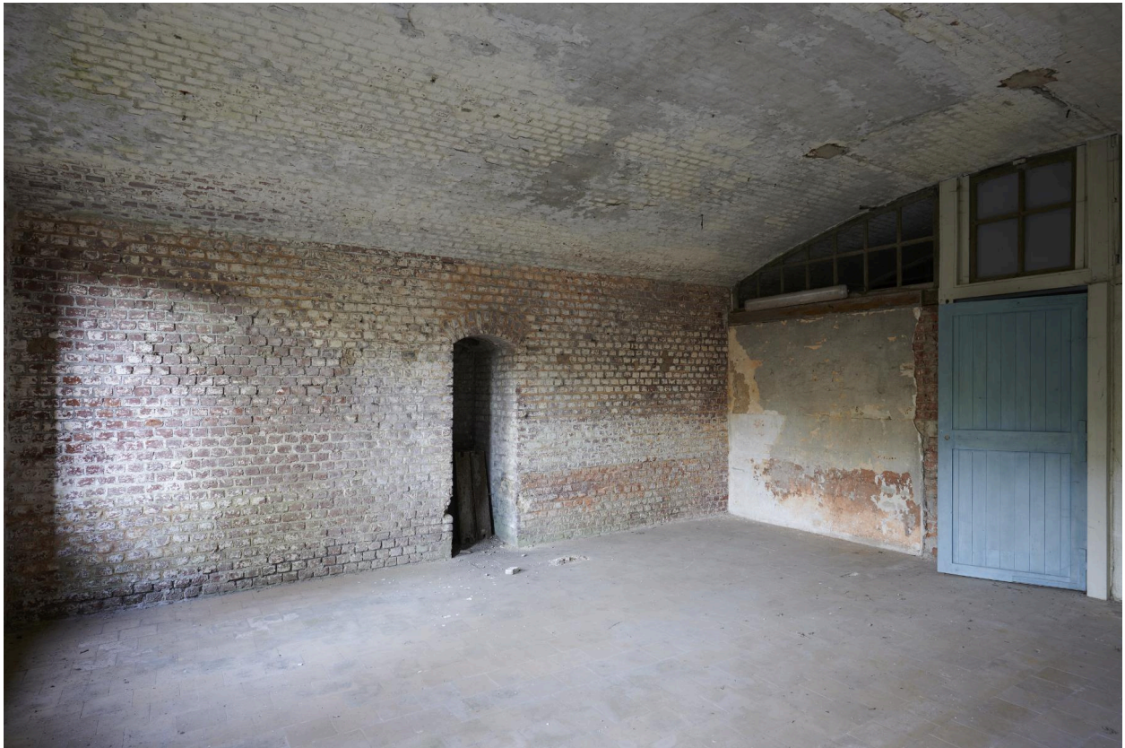
Sous-sol de caserne de gorge. Ancienne tisannerie.
