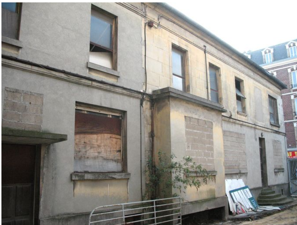
Les bureaux encadrant l'entrée des entrepôts.
