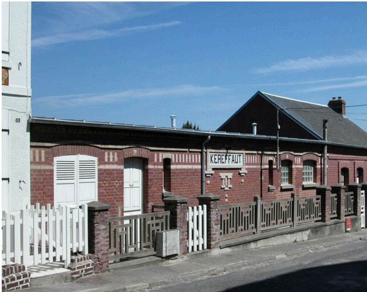
Vue d'ensemble depuis la rue Gros.
