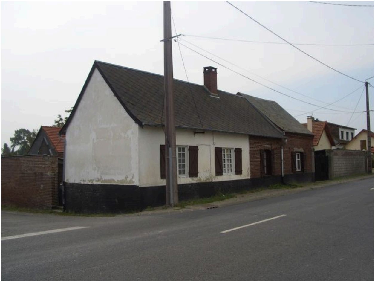
Vue d'ensemble depuis la rue.
