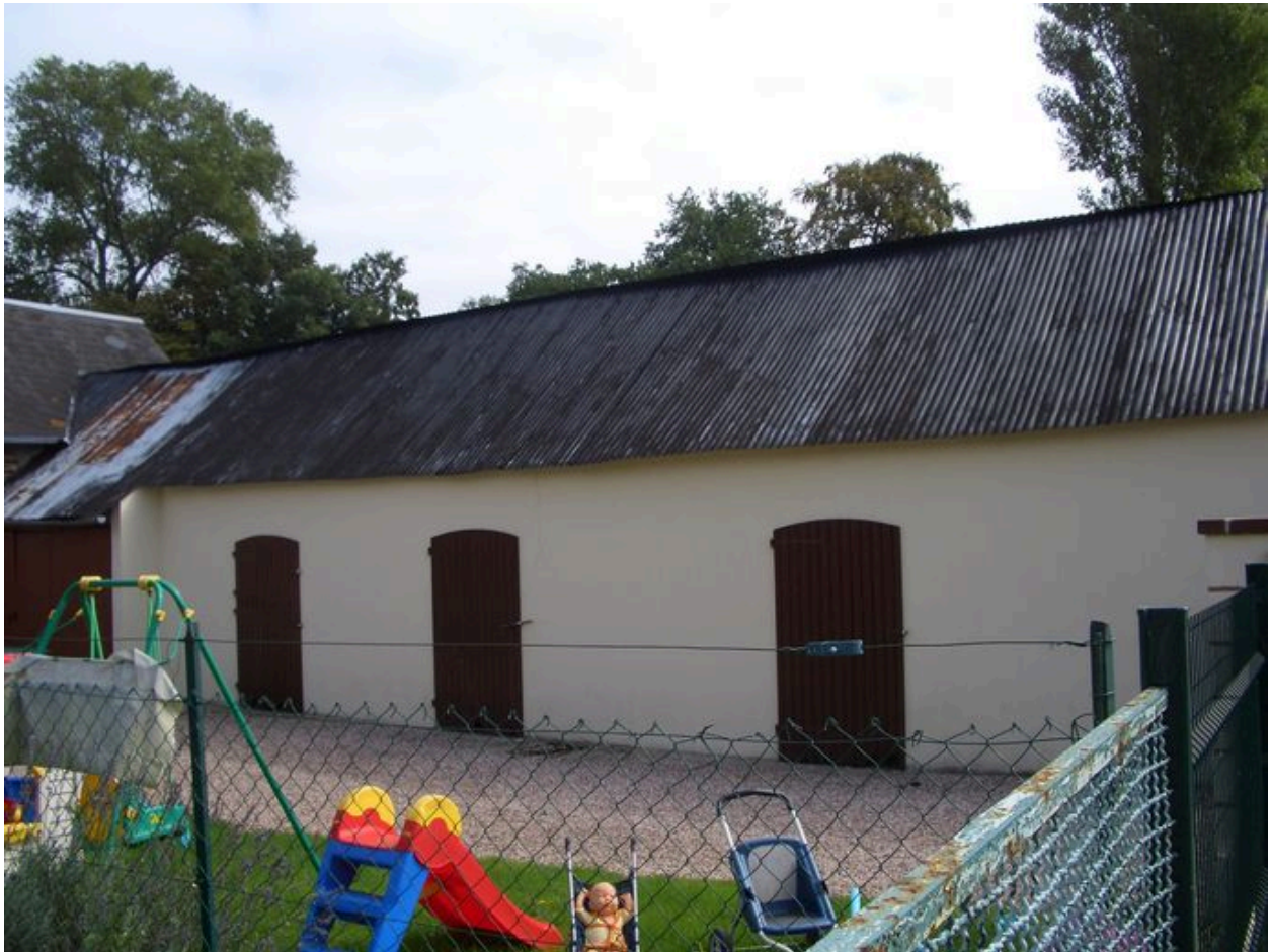
Vue des étables depuis la cour.
