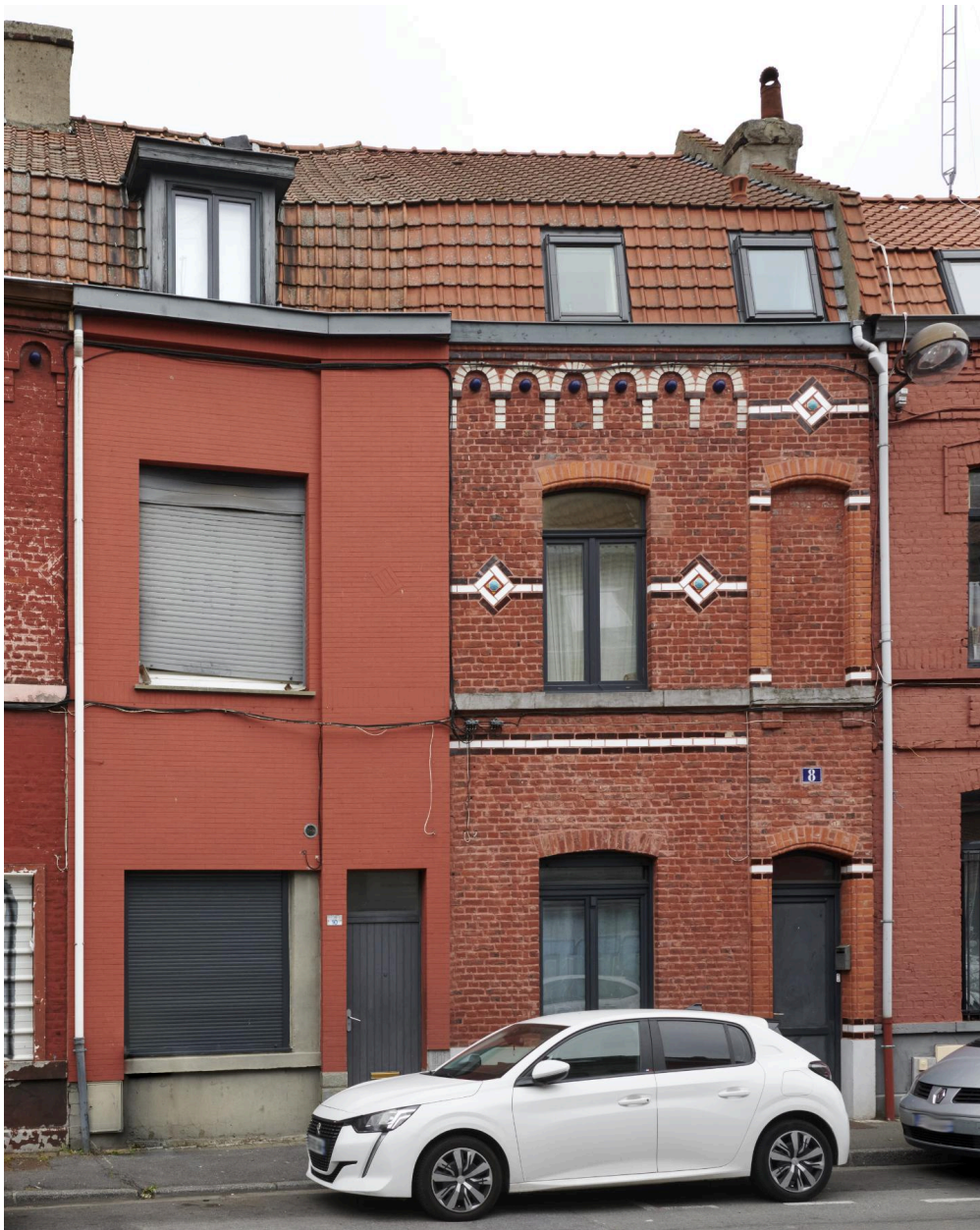
Vue d'une façade.
