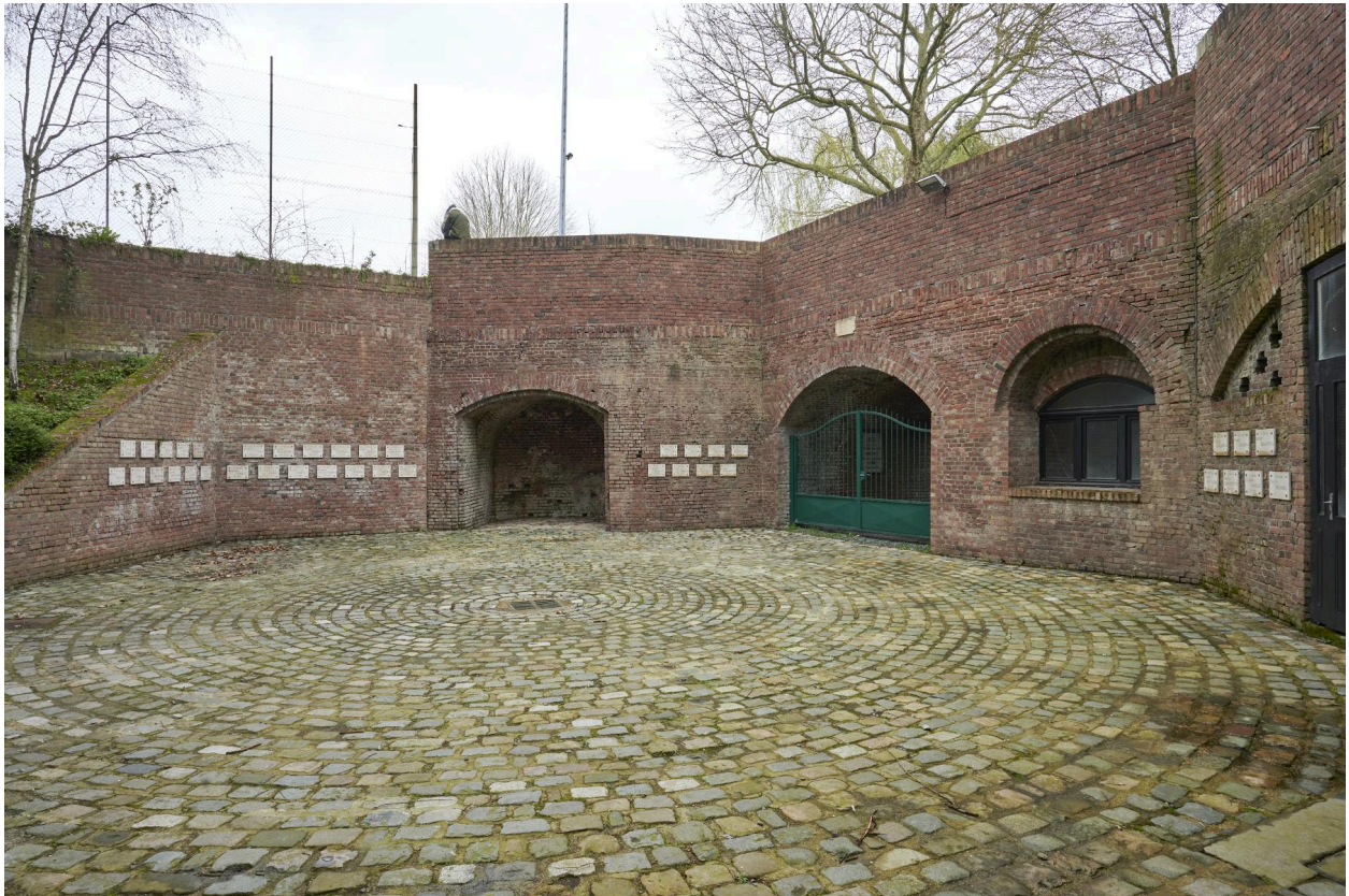
Magasins et latrines ouest.
