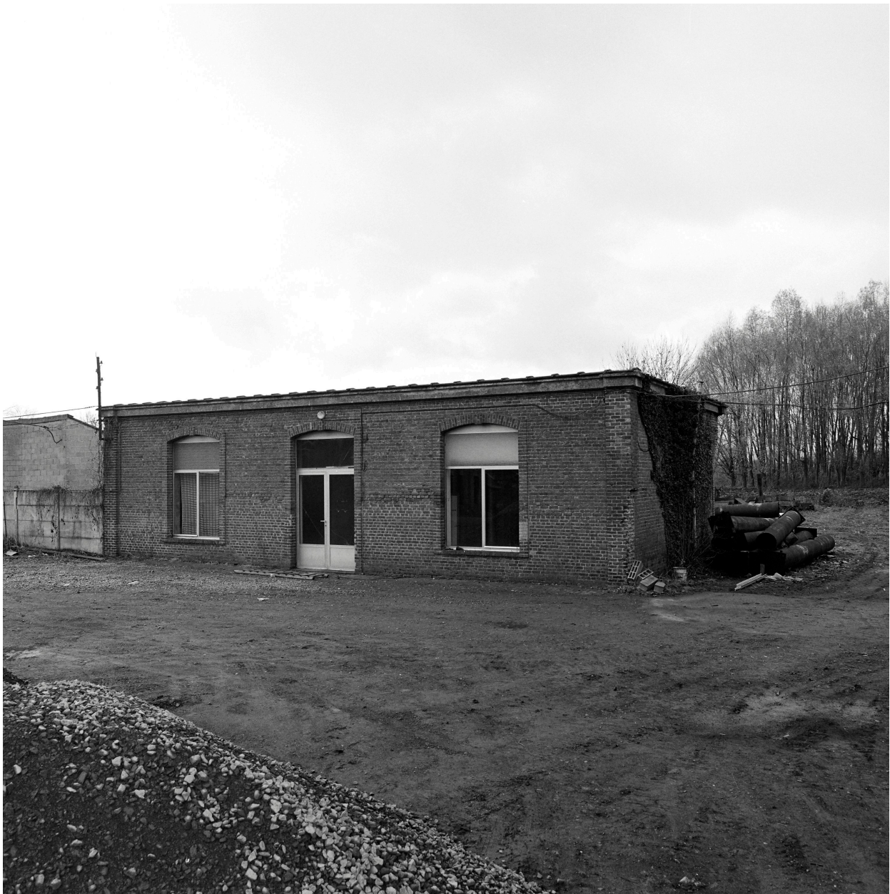
Entrepôt industriel (bâtiment F).
