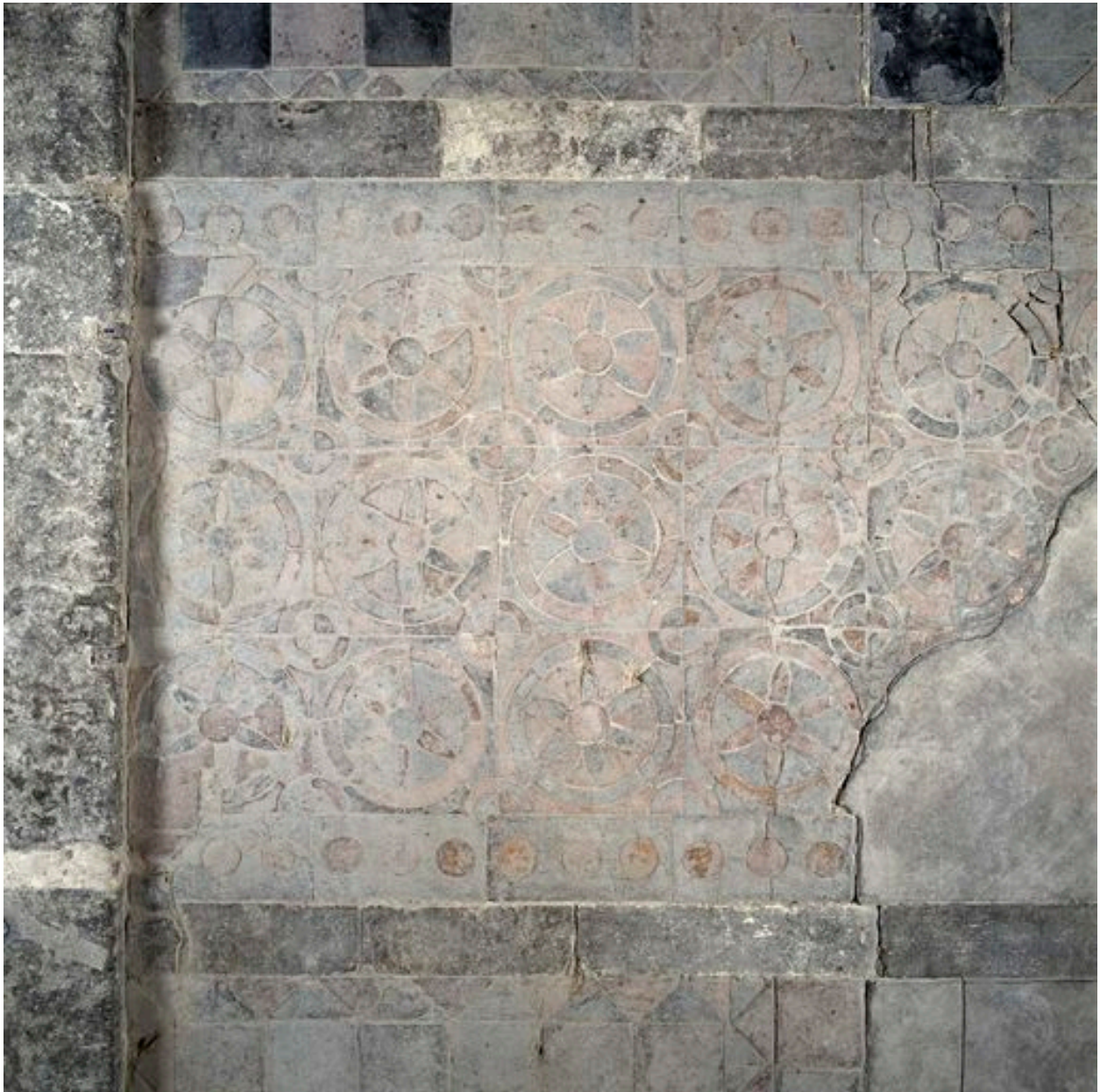
Détail du carrelage.
