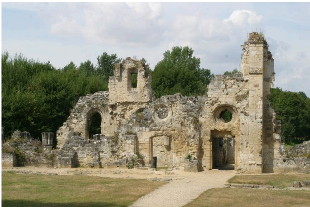
Vue partielle du bâtiments des convers.
