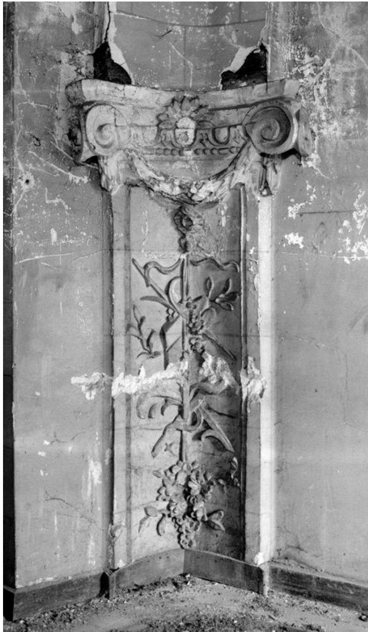
Abside nord : détail du décor du 1er étage.
