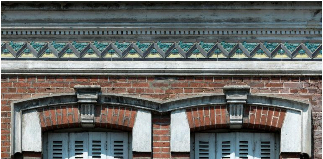
Détail des linteaux de fenêtres et de la frise en céramique architecturale.
