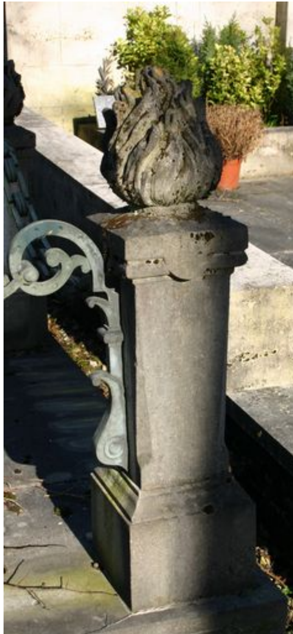
Détail de l'un des poteaux de clôture.
