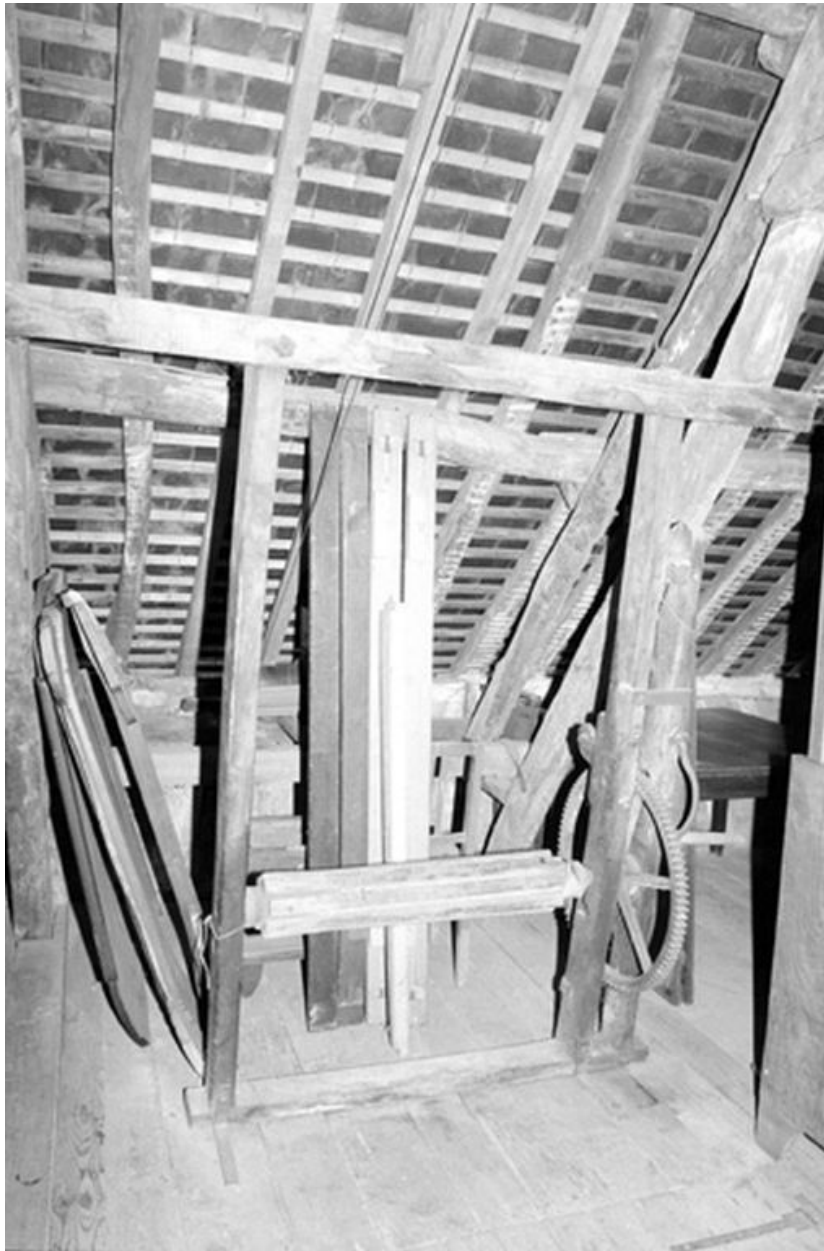
Atelier de fabrication, monte sacs (étage de comble).
