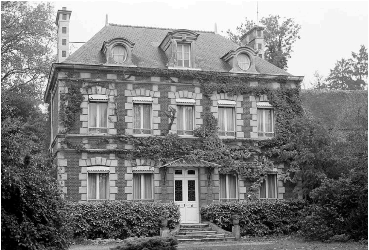
Maison patronale : façade antérieure.
