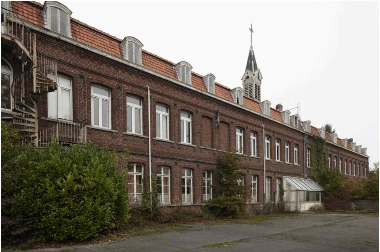
le bâtiment méridional, élévation sud, sur la cour arrière.
