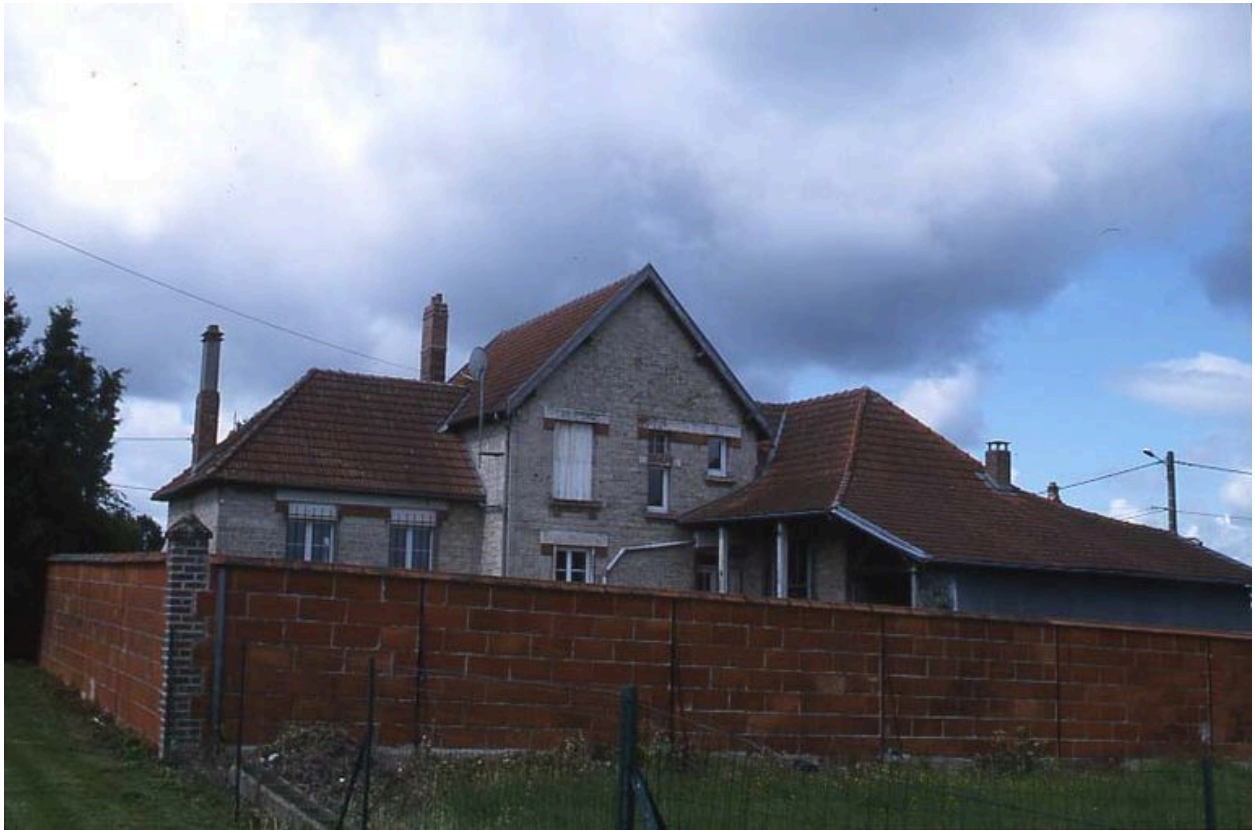
Vue postérieure de l'édifice.
