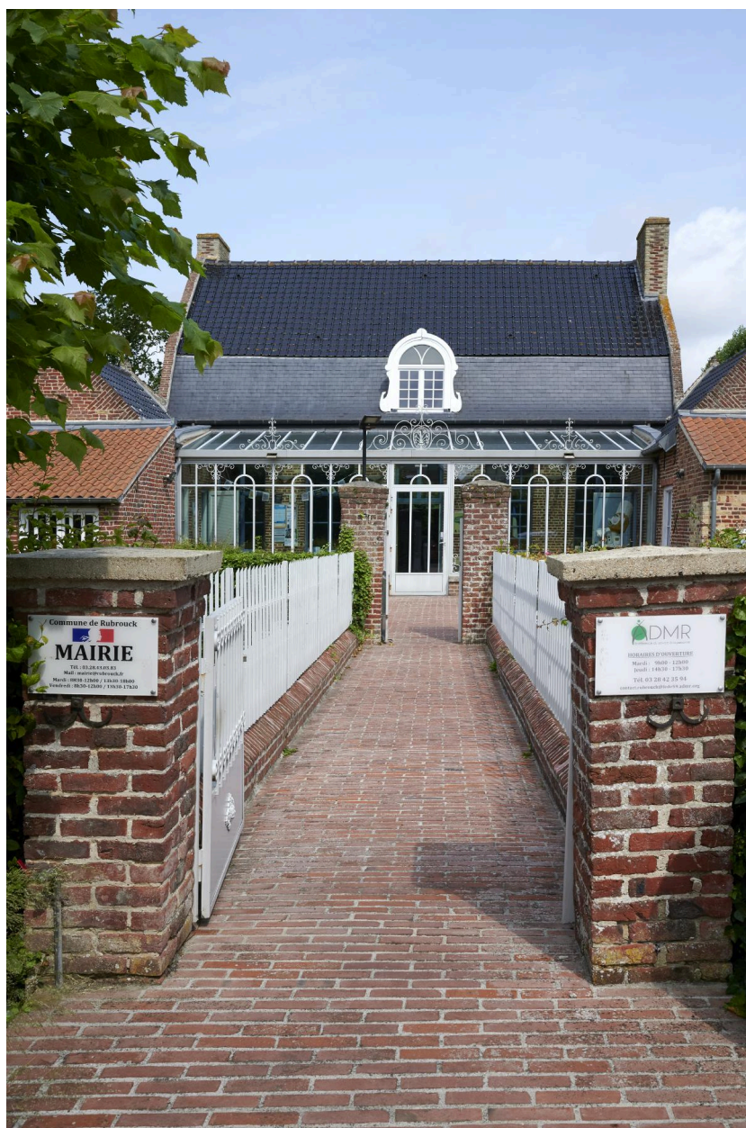
Pilastre du pont, bâtiment principal en fond, vue depuis la rue.
