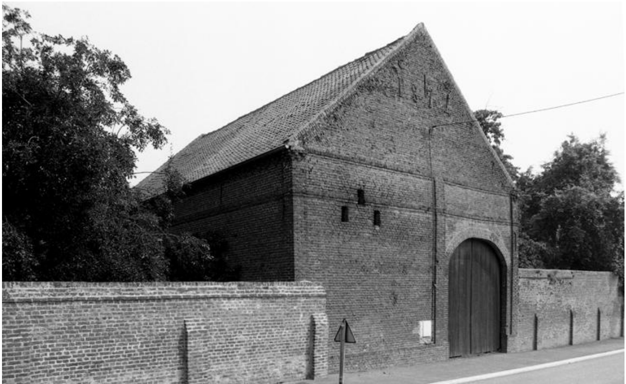
Vue de la grange, depuis le sud-ouest.
