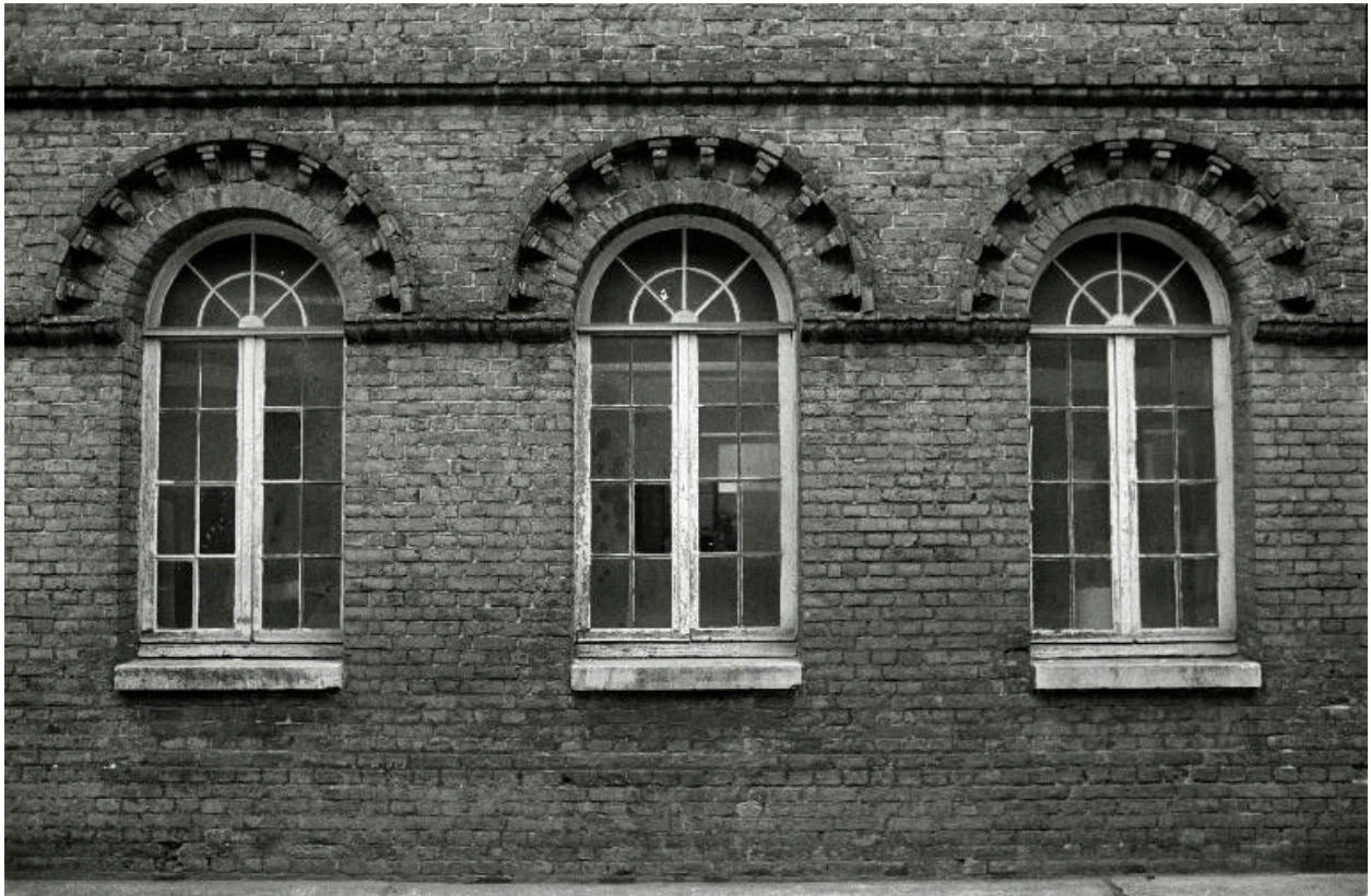
Détail des baies de l'atelier de fabrication, en 1990.
