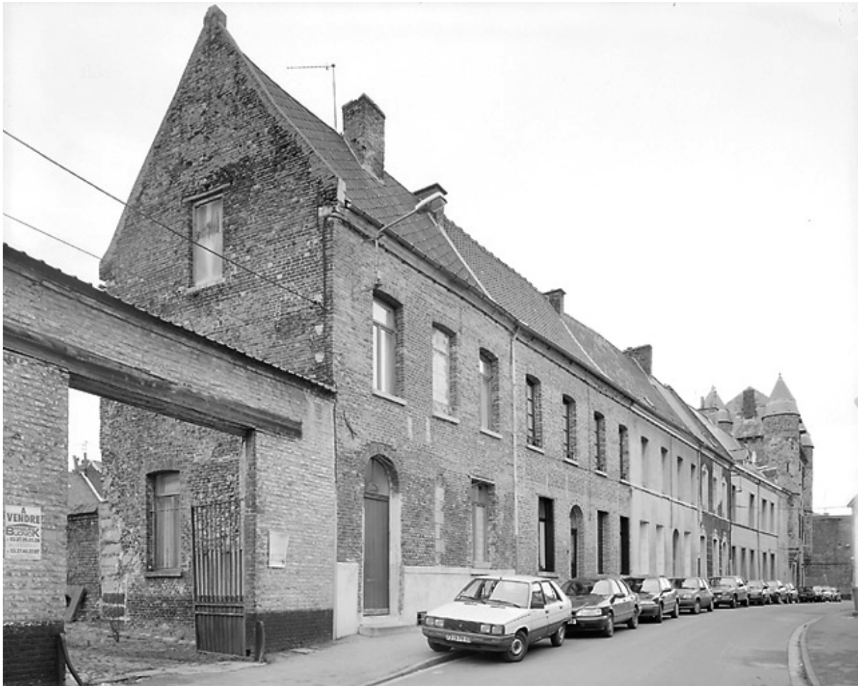
Aile de la rue de la Cavalerie : vue en enfilade du n° 27 vers le n° 37, état en 2001.
