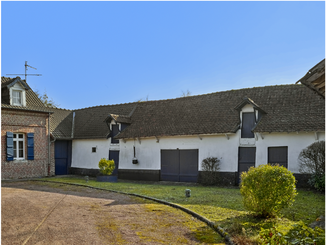
Vue nord d'un ancien édifice agricole, depuis la cour.
