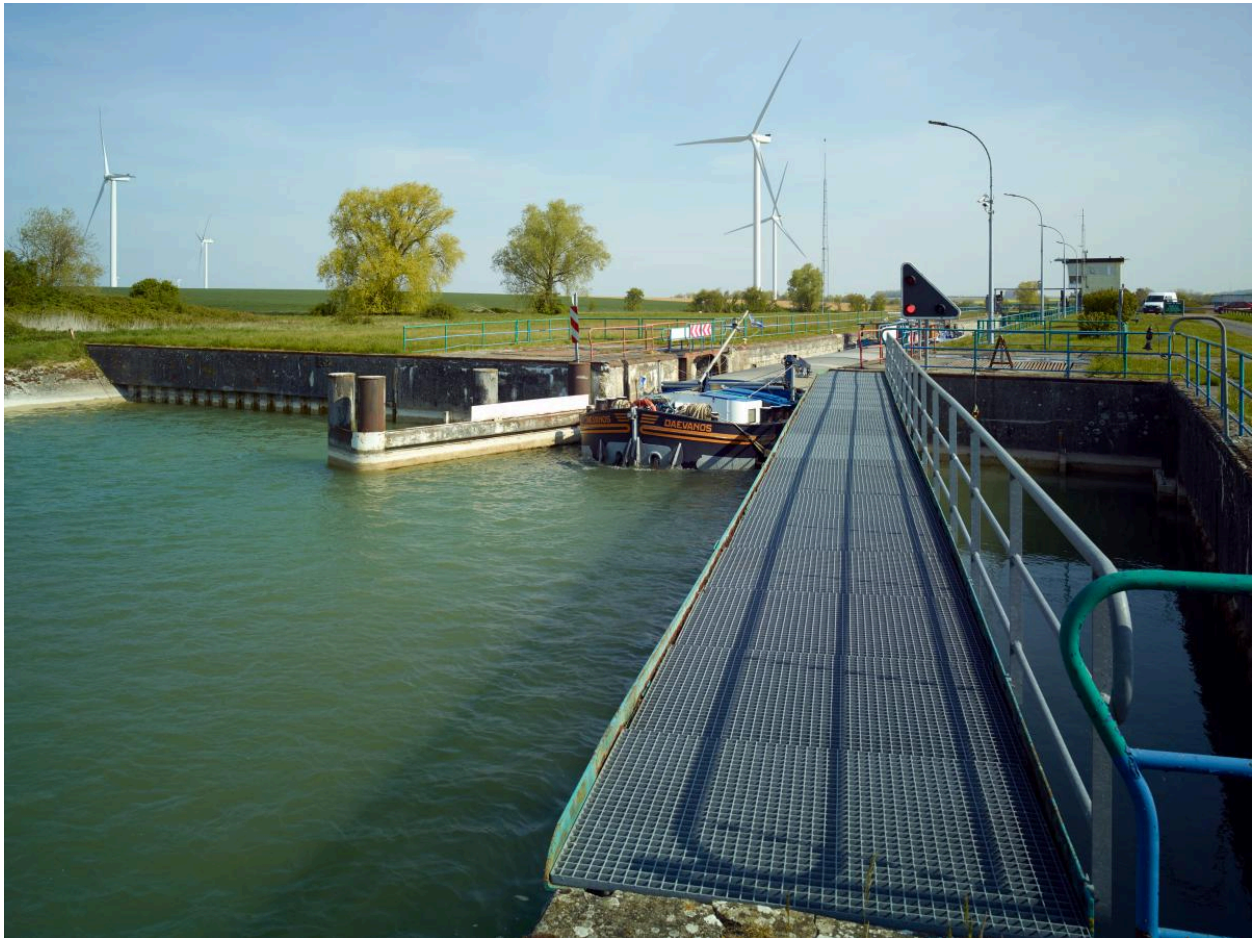
Vue de la tête amont avec estacade de guidage (passerelle et poteau d'amarrage (type Duc d'Albe)).
