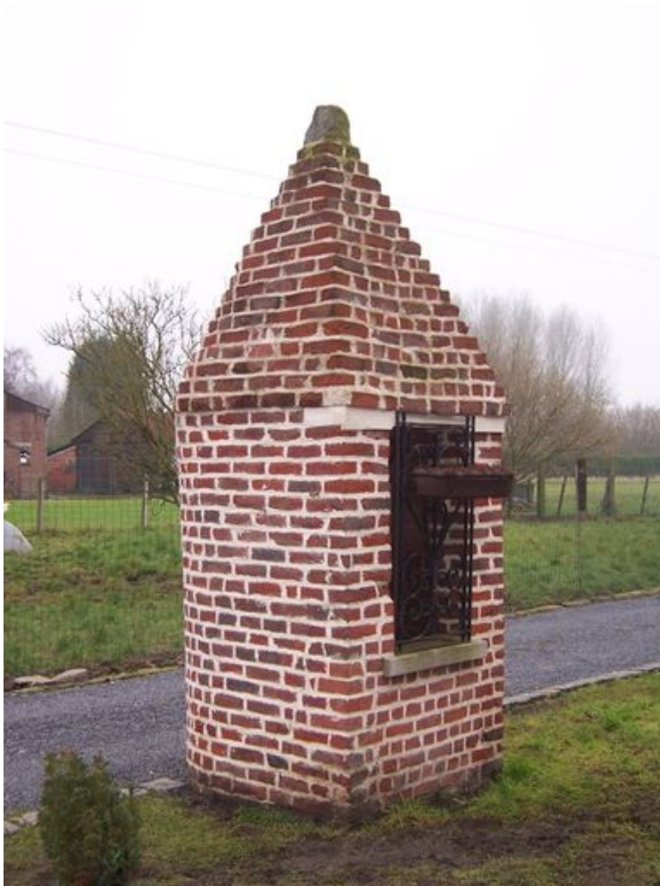
Vue générale du puits F.
