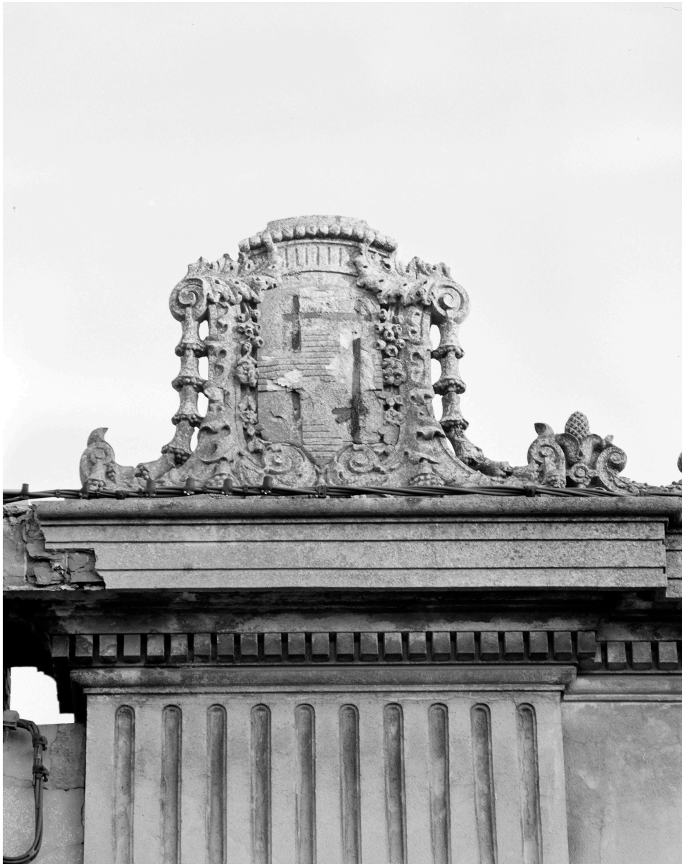
Élévation antérieure. Blason n° 7 (illisible).
