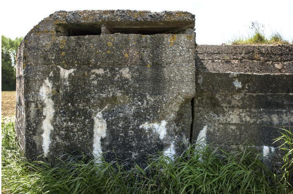
Arrière de l'observatoire casematé
