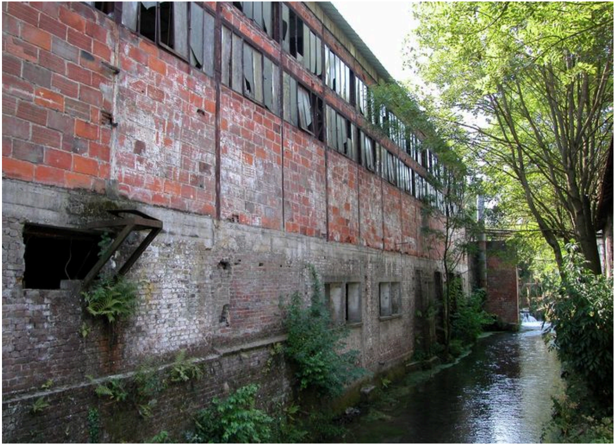
Vue d'ensemble vers l'est des ateliers de fabrication de la fromagerie donnant sur la rivière su Petit-Thérain.
