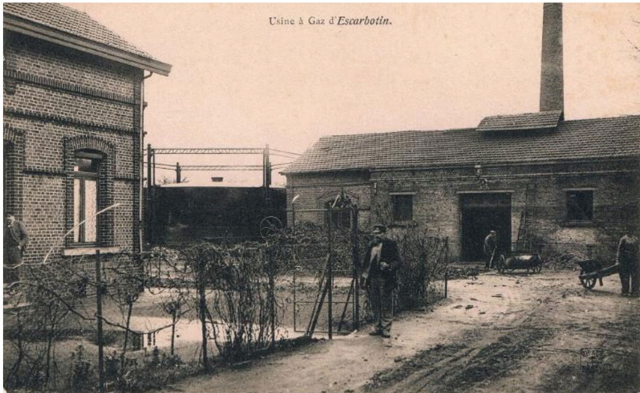
Vue générale de l'ancienne usine à gaz d'Escarbotin, vers 1905 (coll. part.).
