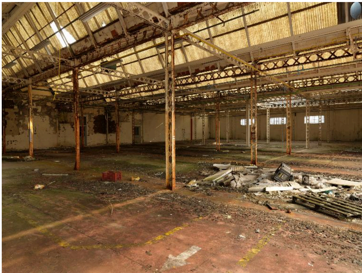
Vue intérieure des anciens ateliers des tours.
