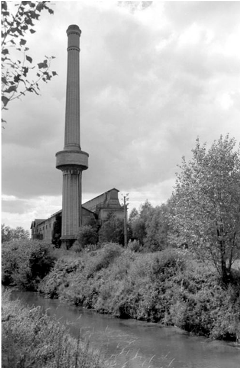
Cheminée d'usine, en 1988.
