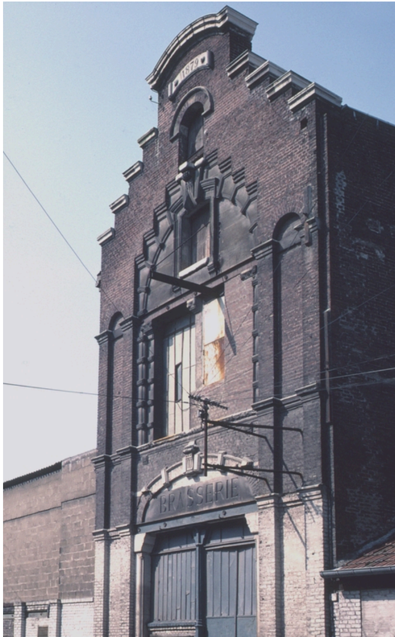
Les ateliers de fabrication vus depuis la rue de la Pomme-Rouge en 1983 (BM Saint-Quentin).
