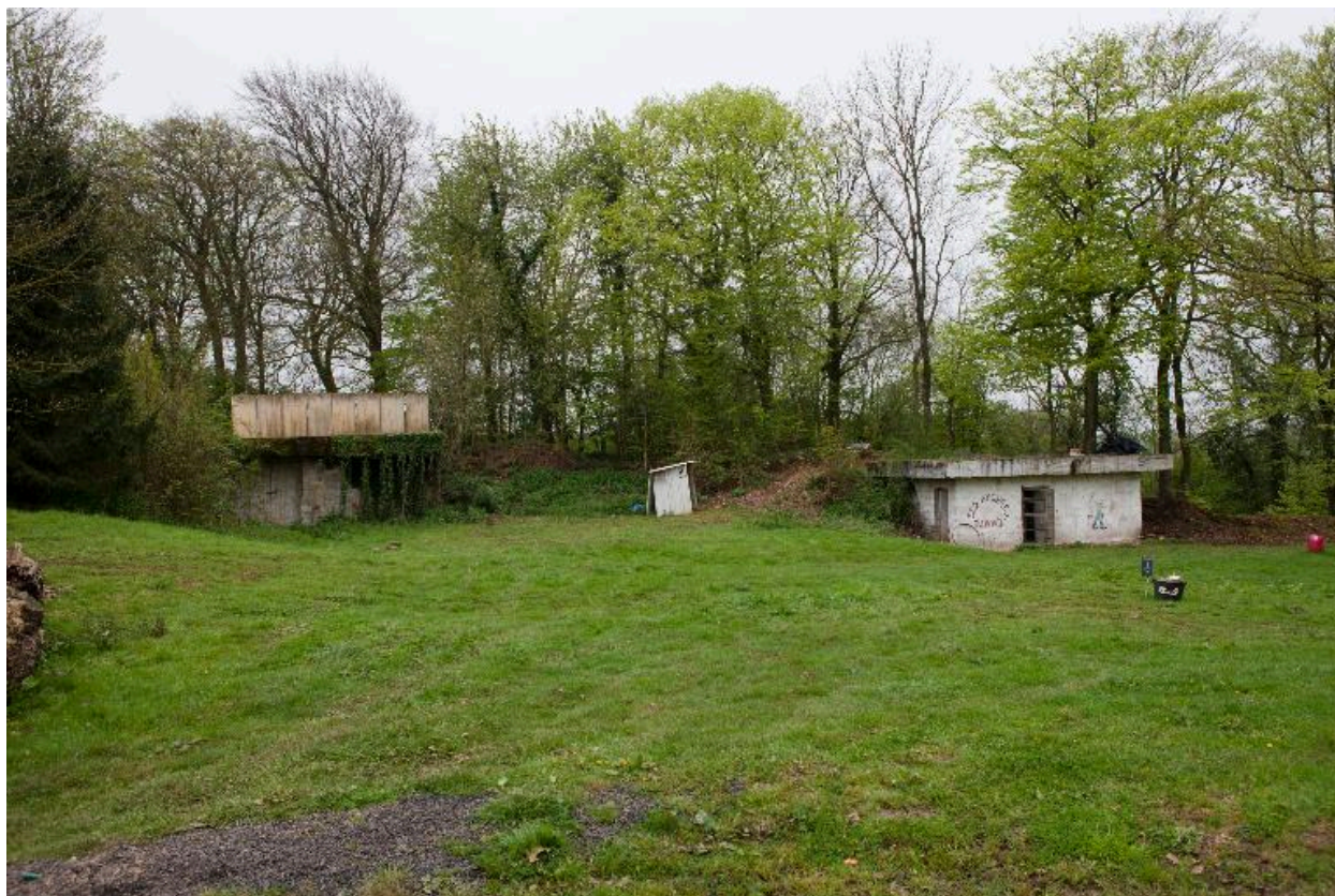
Vue générale des deux abris-casernements.
