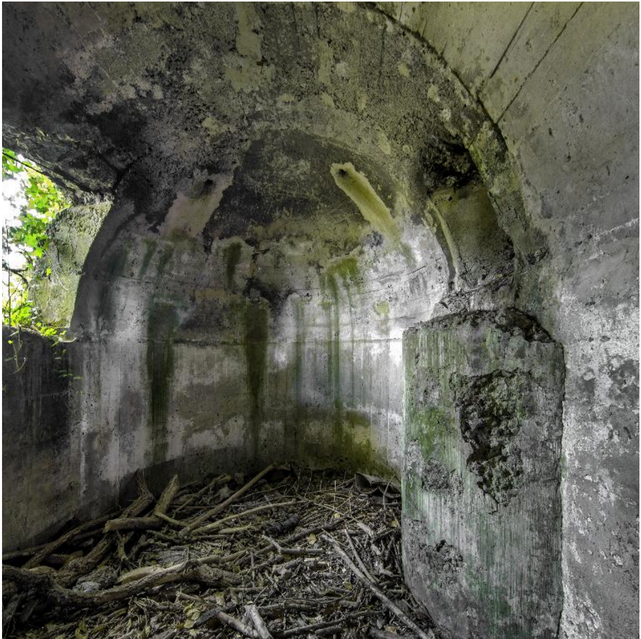
Vue interieur de l'édifice, vers le sud-est
