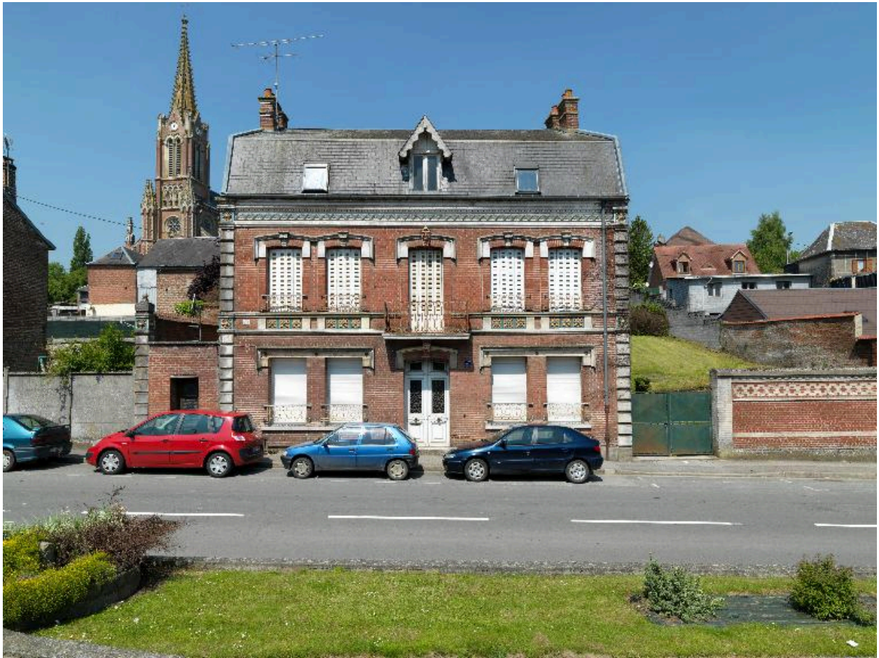
Vue d'ensemble de face.
