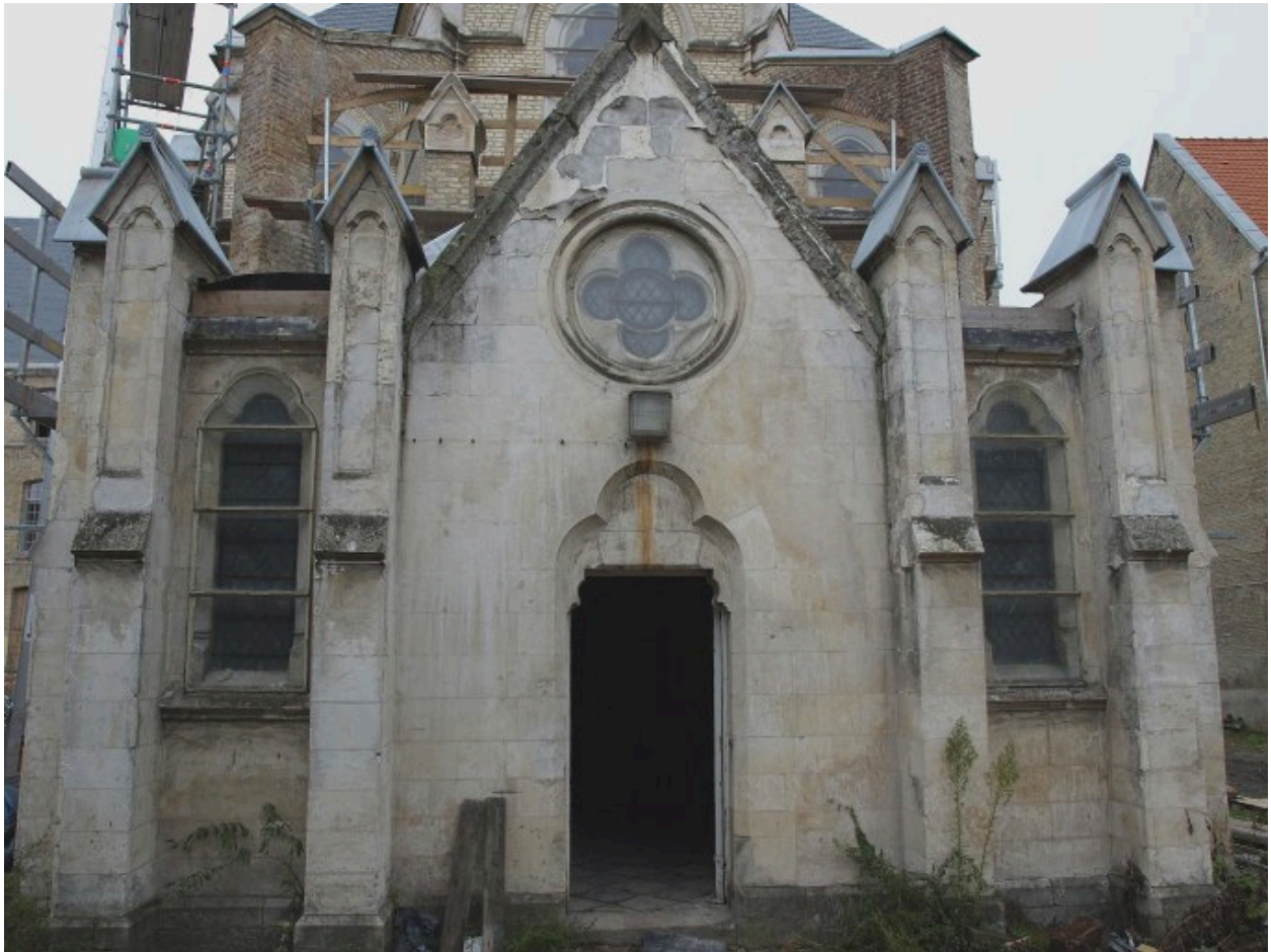
Chapelle, porche donnant accès à la sacristie
