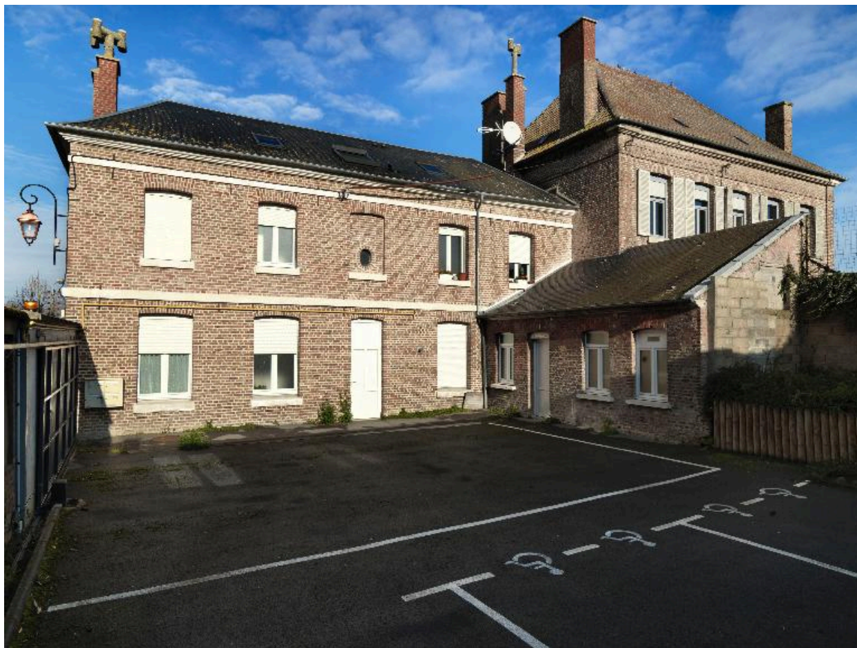
Façade postérieure de l'école.
