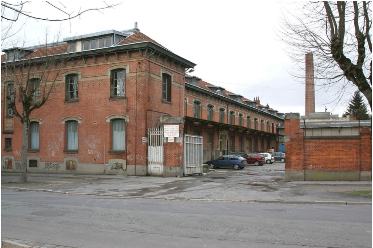
Entrée du site.
