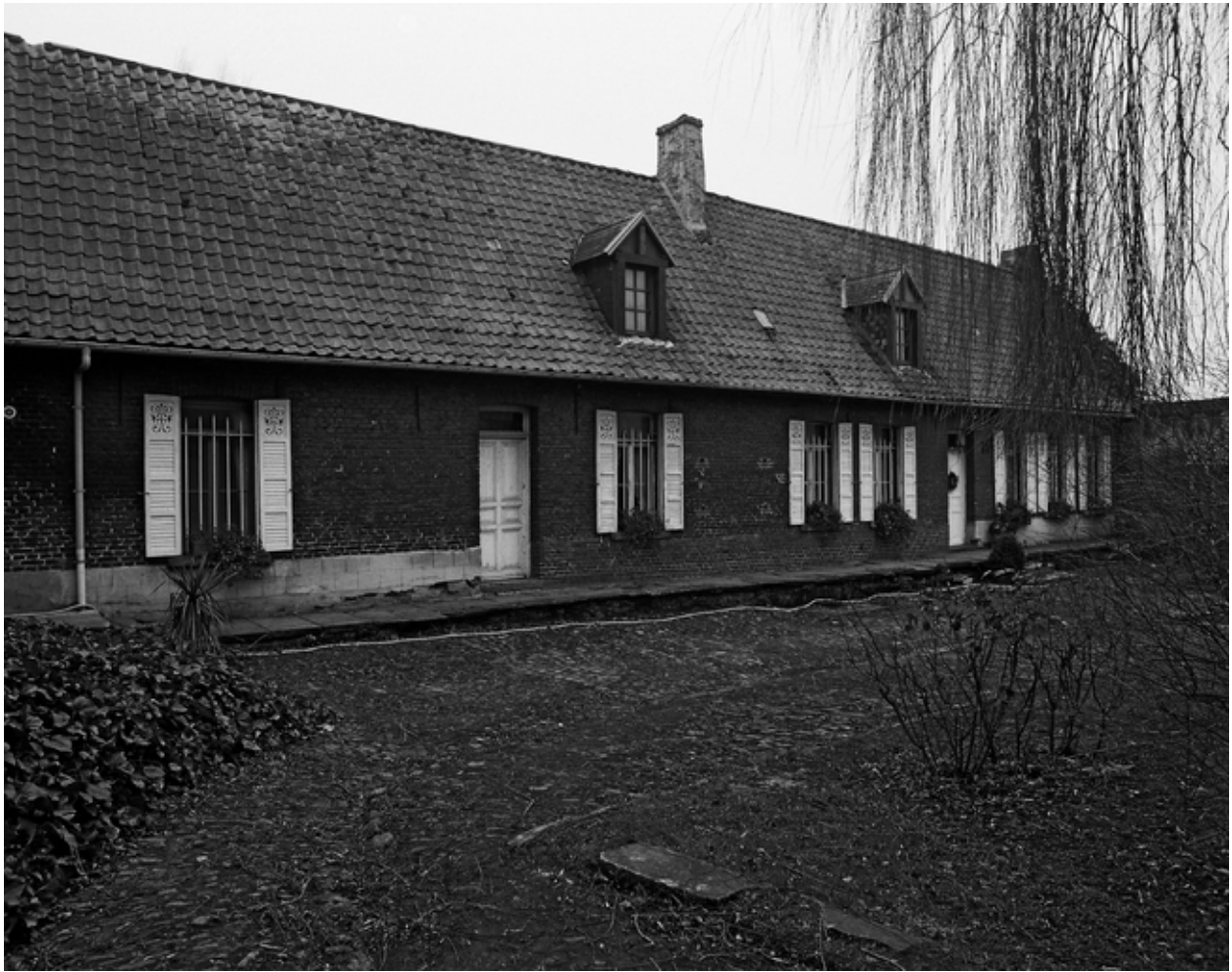
Vue générale de la façade du logis sur cour.
