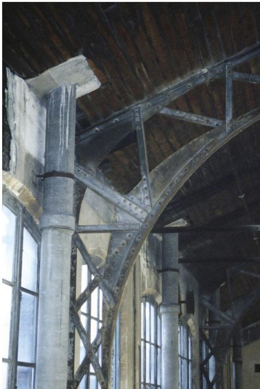
Détail de la charpente métallique rivetée de l'atelier de montage des isolateurs.
