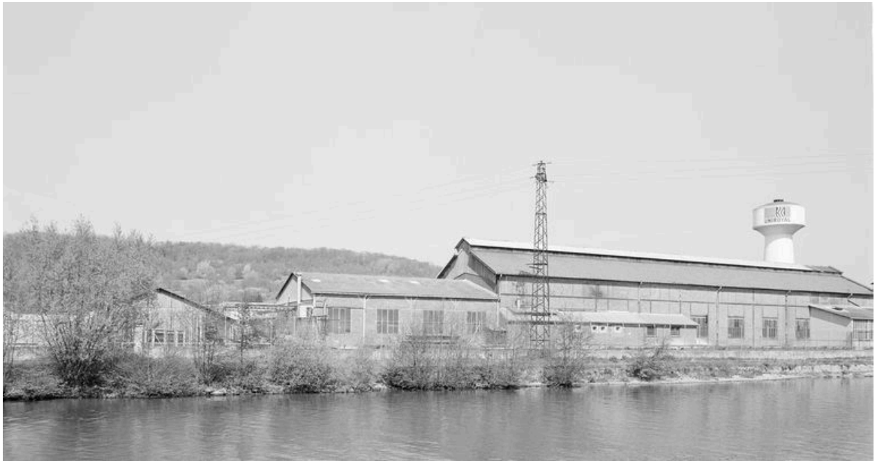
Magasin industriel, vue générale, flanc est.
