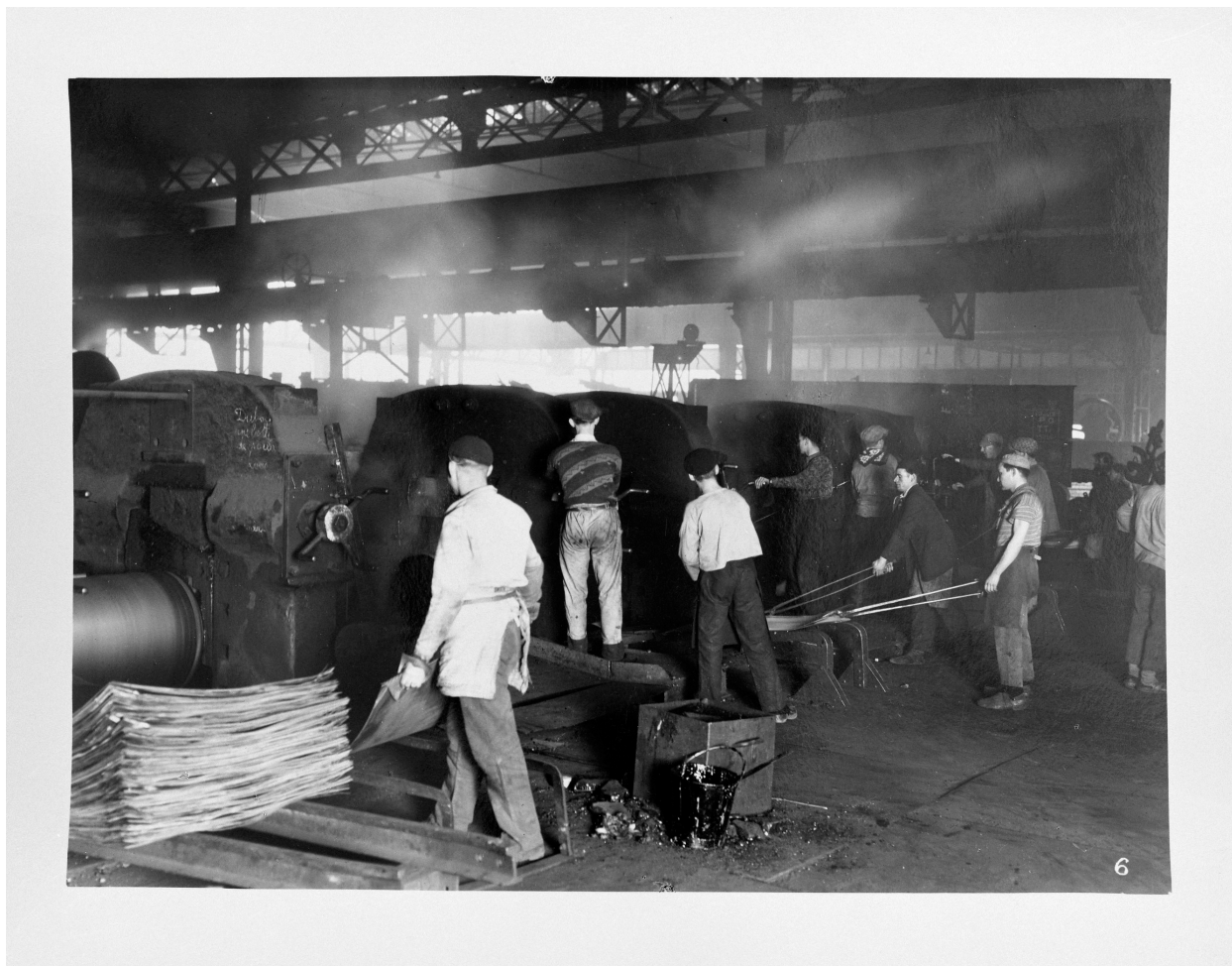
Train à chaud (four et laminoir) à fines tôles. Photographie ancienne, auteur inconnu, sans date (coll. part.).
